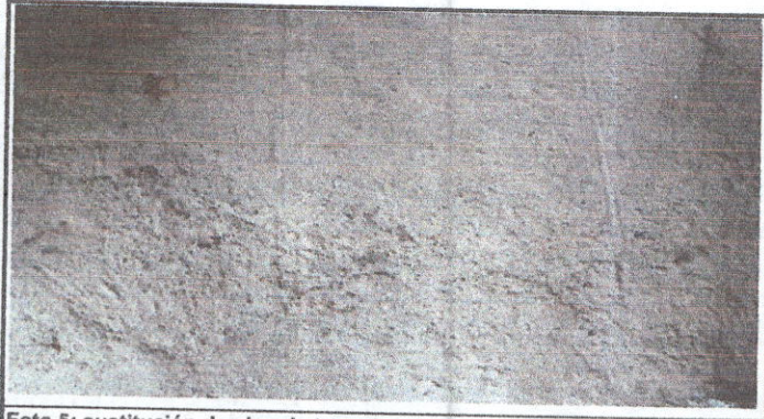
Foto 5: sustitución de piso de torta de concreto
